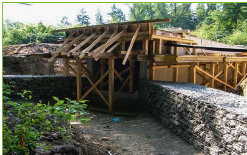
Baustelle Wildkatzendurchlass 2011, zukünftige „Katzen-Perspektive“.
