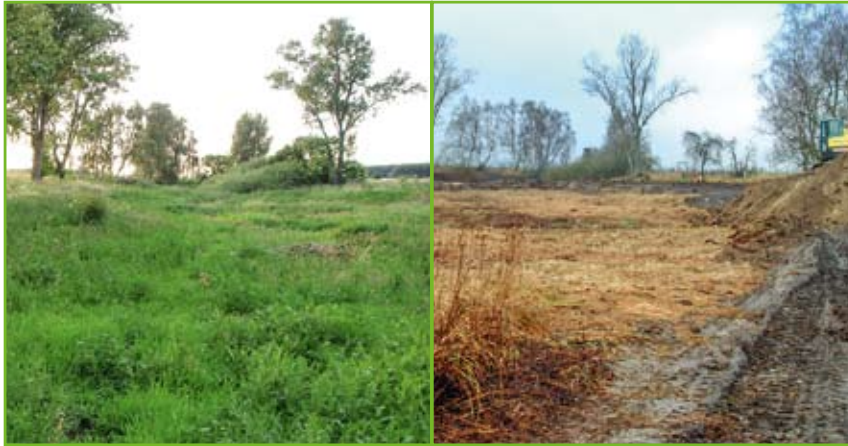
Ausgangszustand und Beginn der Bauarbeiten
