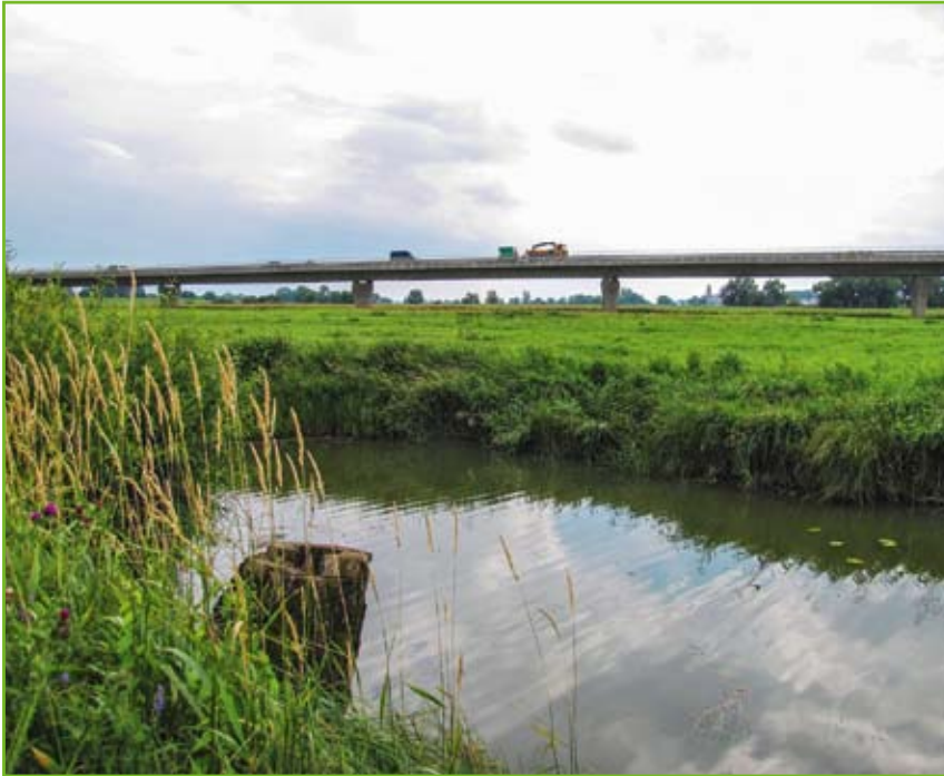
Die aufgeständerte Talbrücke wird von in weiten Abständen platzierten Betonpfeilern getragen. Dem Hochwasserschutz und der Ökologischen Durchgängigkeit wird so in hohem Maße gedient.
