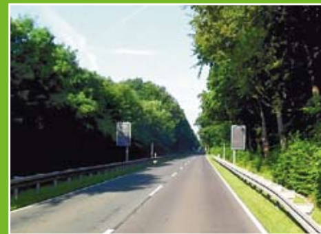
Wildwarnanlage im Ziegelrodaer Forst
