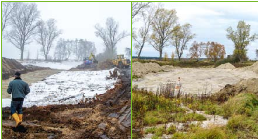
Aushub- und Profilierungsarbeiten
