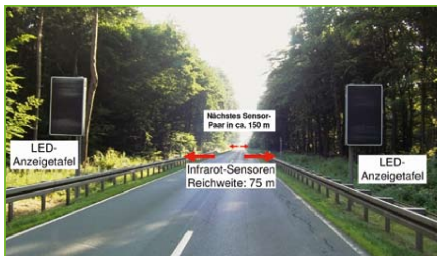
Aufbau einer Wildwarnanlage am Beispiel der Wildwarnanlage an der L 172 im Ziegelrodaer Forst
