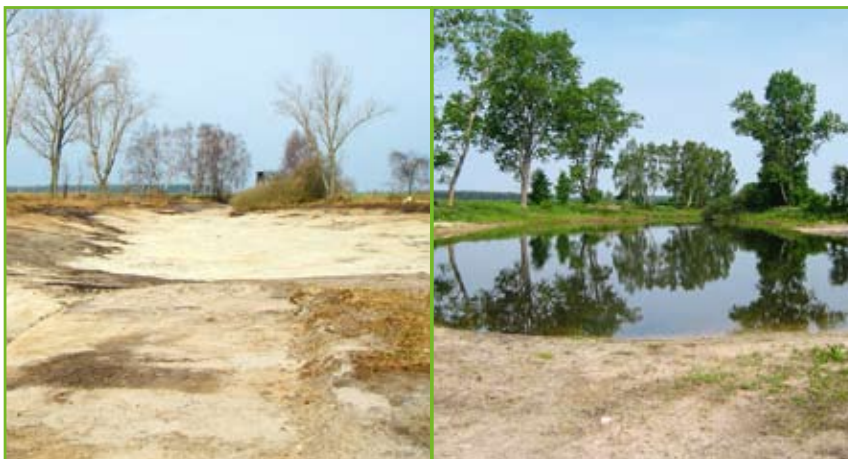
Fertige Profilierung und Endzustand als Gewässer
