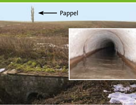
Vorher: der Harsleber Bach im verrohrten Zustand
